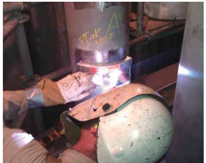
Wykwalifikowany pracownik podczas prac instalacyjnych - montaż termometrów powierzchniowych.
